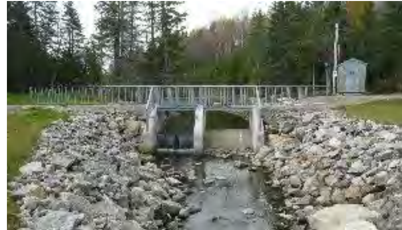
Barrage au lac Cornu à Mont-Blanc (Source : CEHQ)
